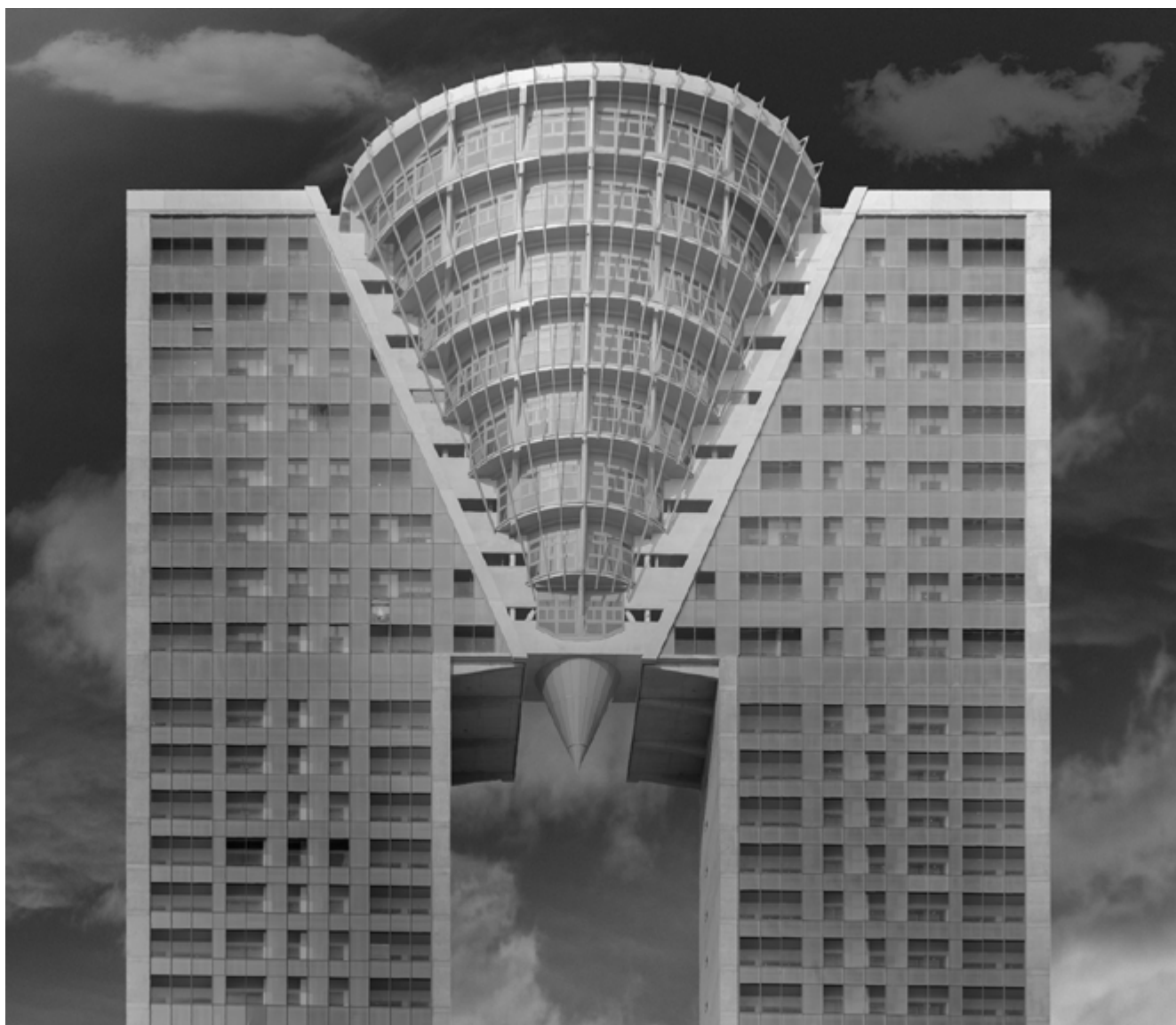
Categoría Arquitectura e Interiorismo. LUX Plata: Joan Gil por su obra "In tempo"
