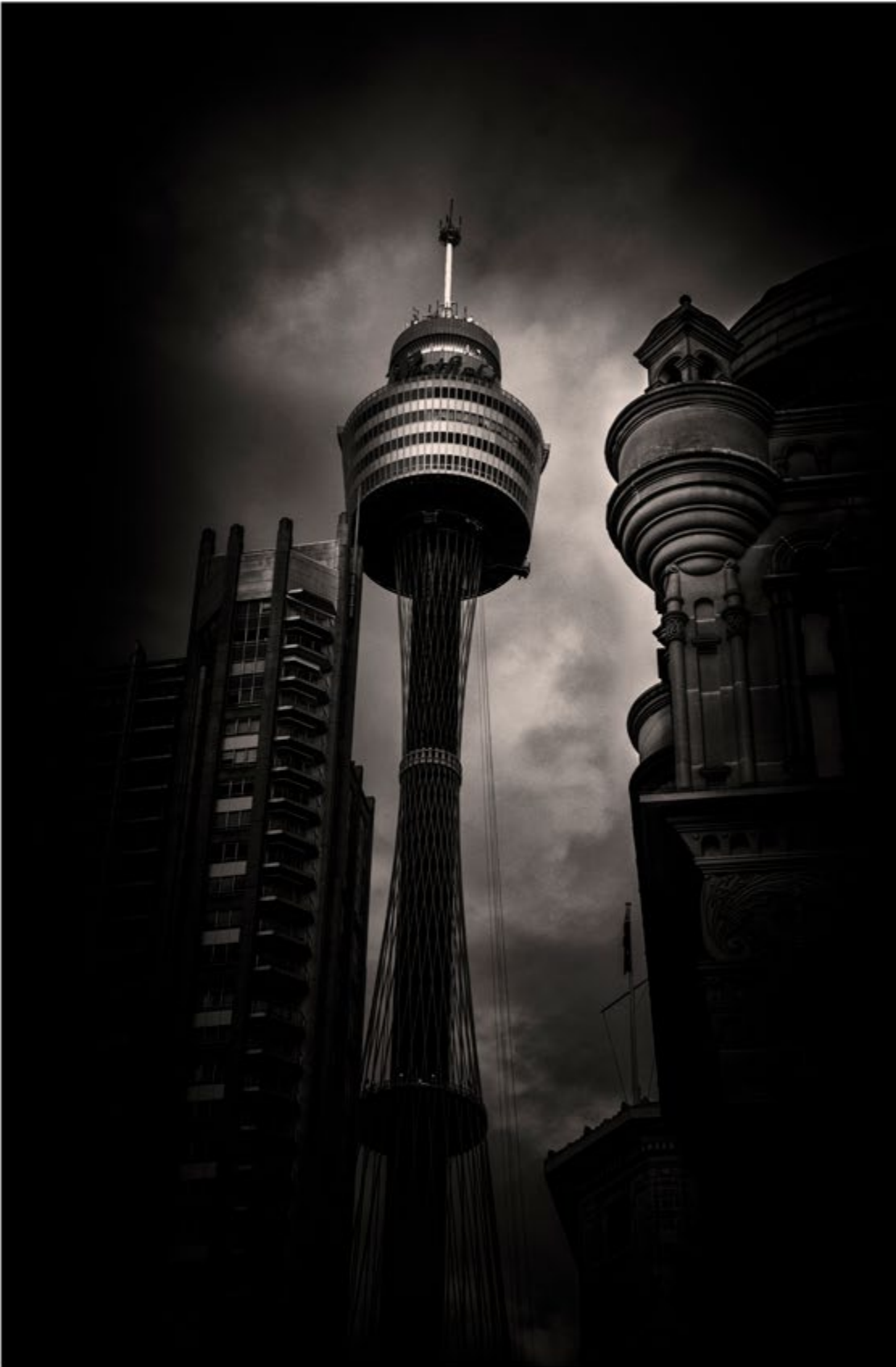
Sydney Tower La torre se sustenta con 56 cables de acero, cada uno de los cuales pesa 7 toneladas con 309 metros de altura
