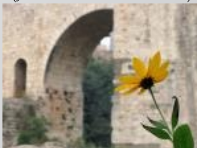
Mirando el puente (Juan Cárdenas Cárdenas)
